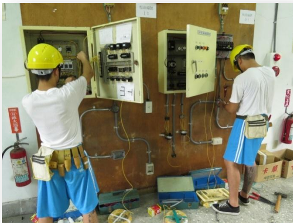
室內配線檢定現場照片
